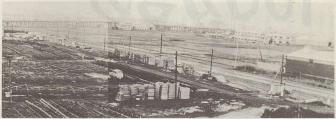
(6月)鉄骨地組・地中梁コンクリート打開始。
